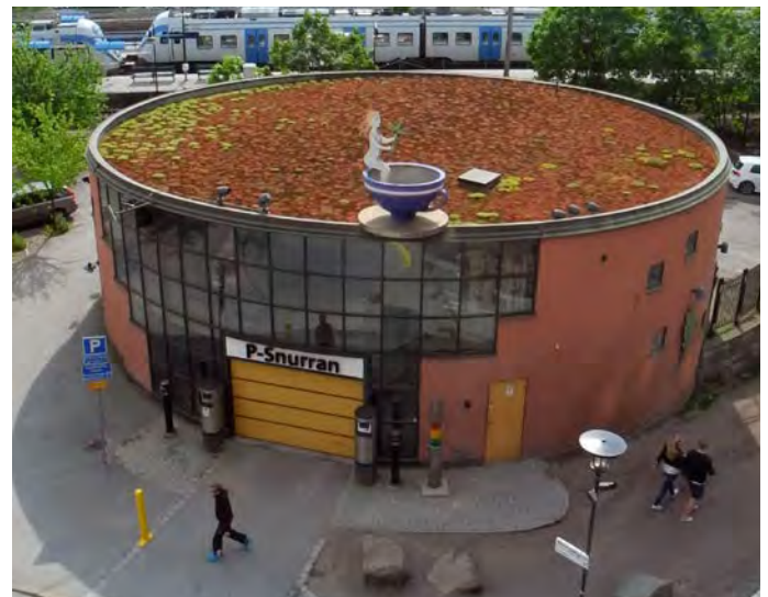
Automatiskt parkeringshus i Stockholm. Källa: www.stockholmparkering.se
