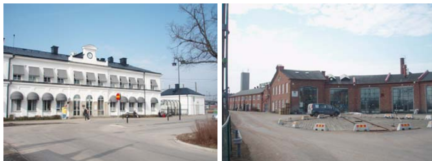
Karlskrona järnvägsstation och lokstallarna.
