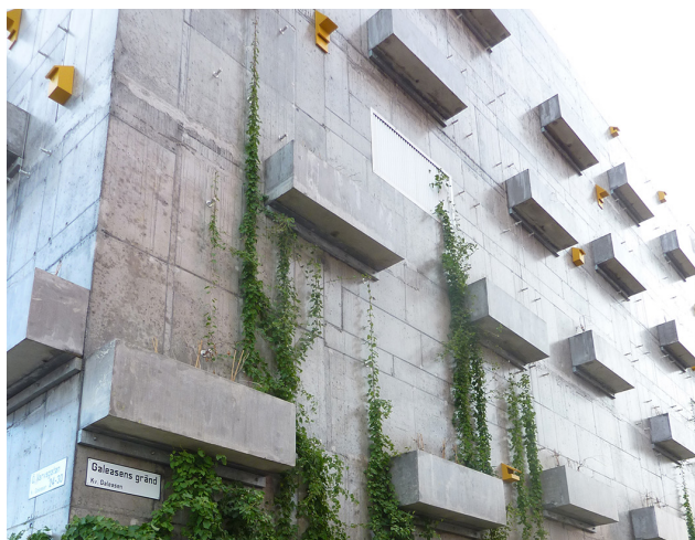
Exempel på holkar samt grönska på fasaden.
