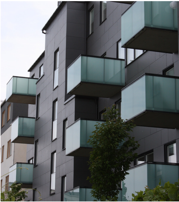
Exempel på balkonger som ger karaktär åt fasaden.
