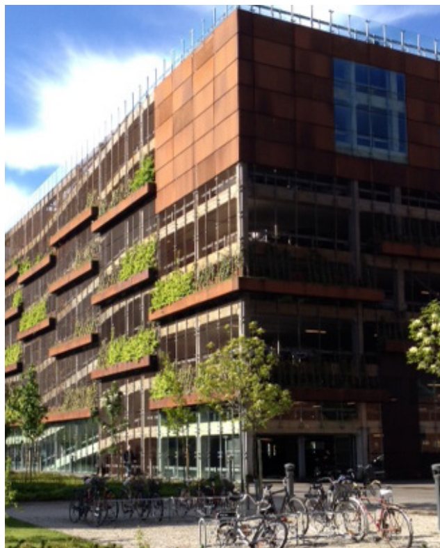
Exempel på parkeringshus med grön fasad.
