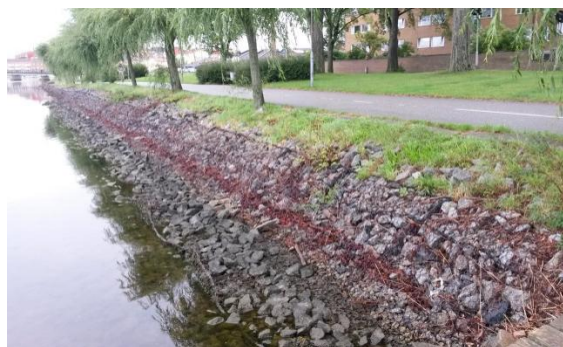
Bild 3. Stenfyllda gabioner
