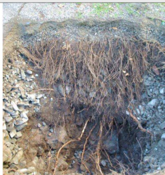
Figur 10: Exempel från Narvavägen på uppbyggnad av skelettjord (Örjan Ståls föredrag "Träd och dagvatten" på Rörnätskonferensen i Malmö 1-2 april 2014).
