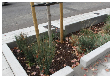
Figur 6: Rain Gardens i anslutning till lokalgata, (Dagvattenseminarie, exempel från Portland i USA, Stockholm 2012 samt VAK, SWECO, 2014).
