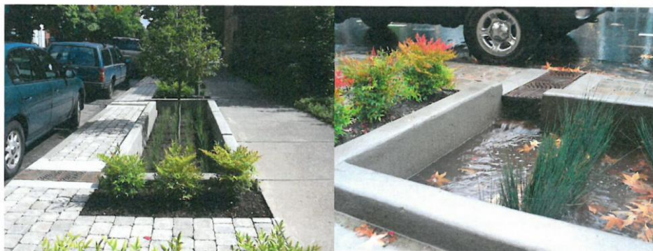
Figur 7: Rain Gardens vid torrtilfälle och regntillfälle i anslutning till trottoar och gatuparkering, (Neptunigatan biofilteranläggningar (ex från USA) VASYD 2014).
