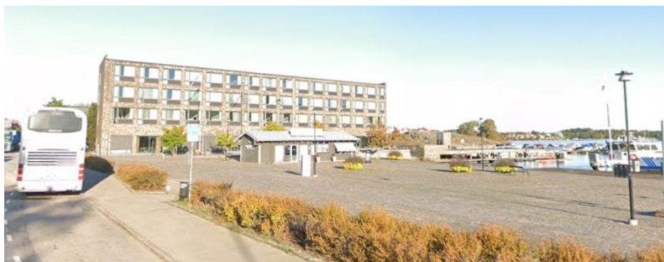
Bild 23. Befintlig byggnad för biljettförsäljning på Fisktorget med Scandic hotell i bakgrunden.
