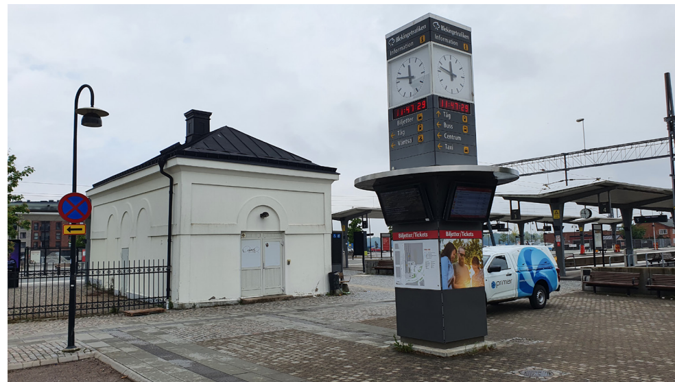
Den norra flygelbyggnaden.
