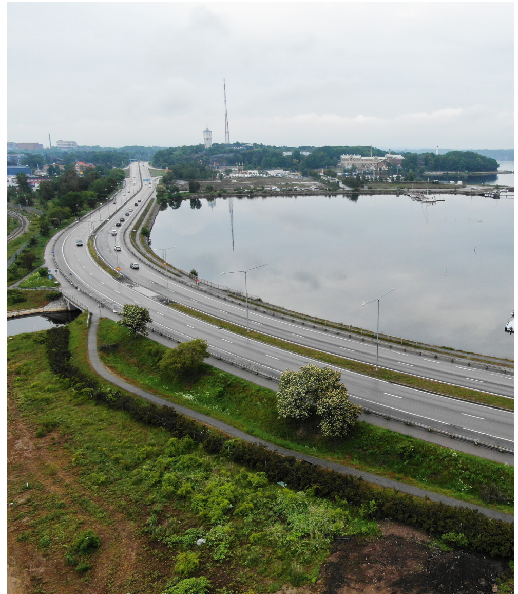
Drönbild över Österleden. Vy mot nordost.
