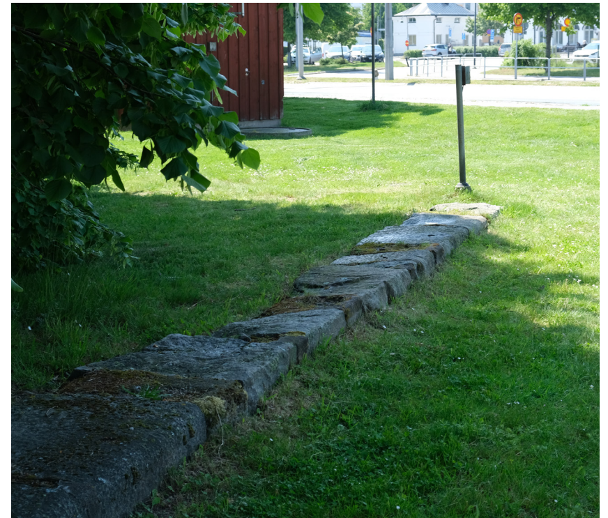
Murfundament i norra delen av karaktärsområdet. Vy mot väster.
