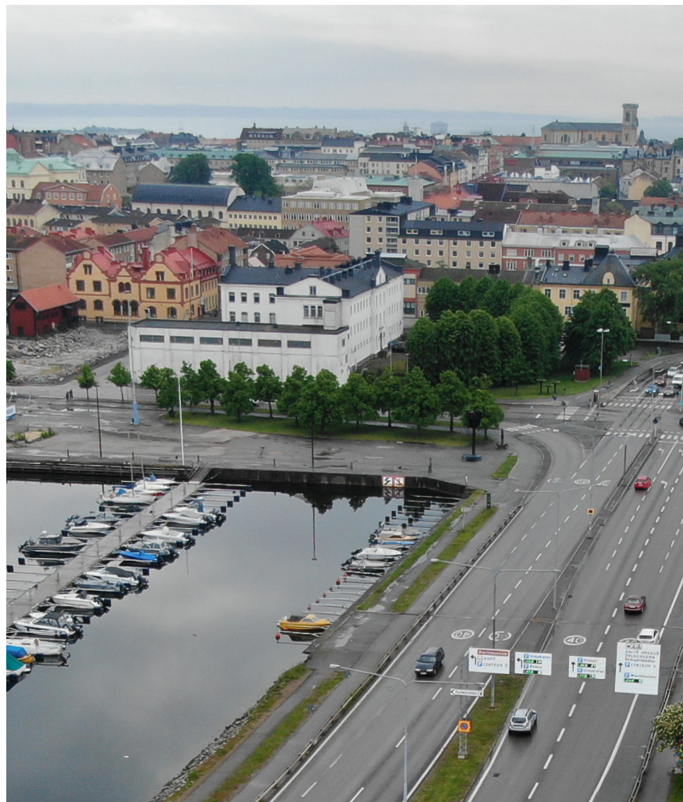
Drönbild över karaktärsområdet, med fängelset i bakgrunden. Vy mot sydost.
