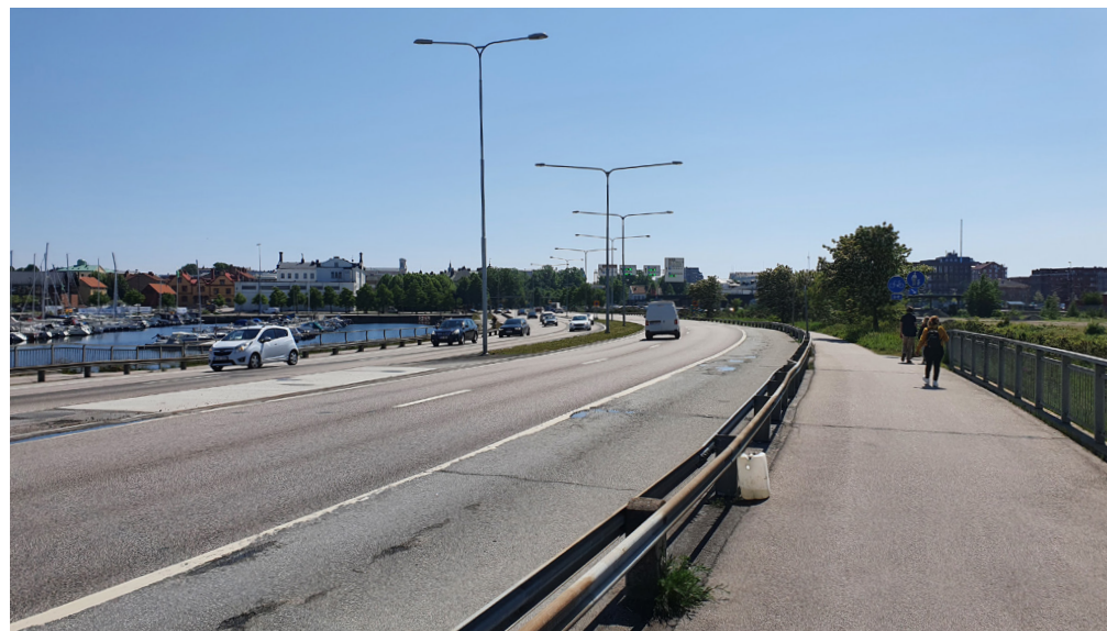
Österleden. Vy mot söder från Brohålan. Till vänster i bild marinan vid Skeppsbrokajen och fängelset.
