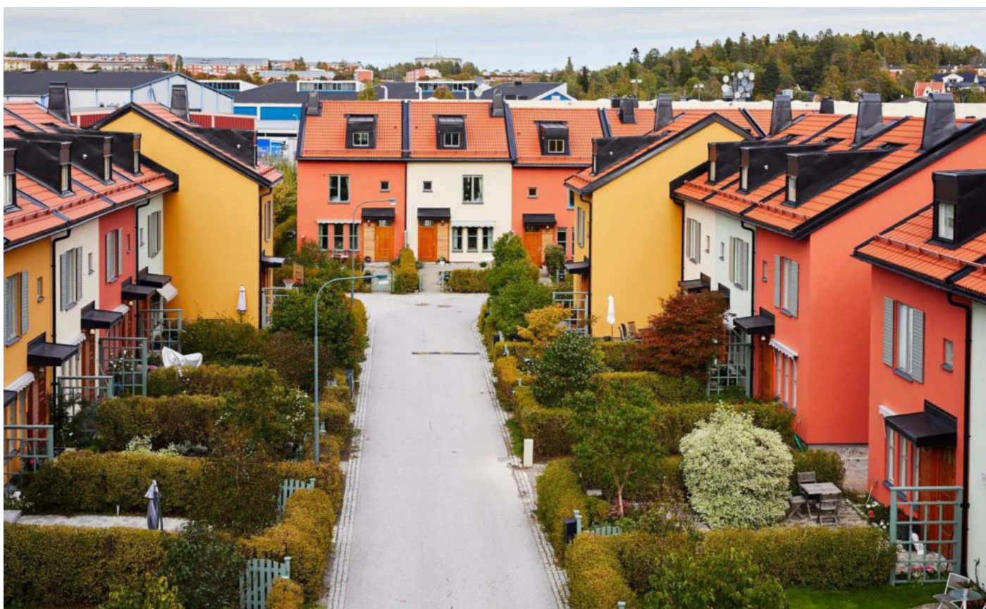
Område i Spånga, Stockholm, byggt utifrån trädgårdsstadens ideal. Foto: DM Tak AB
