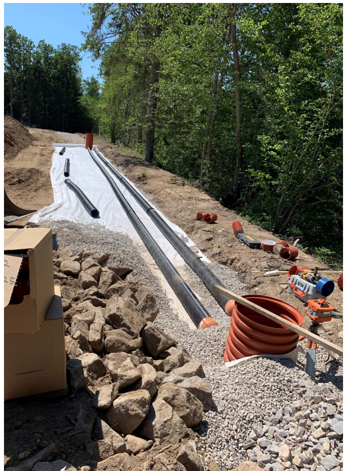
Pågående anläggning av bevattningsmagasin inom Torstäva.
