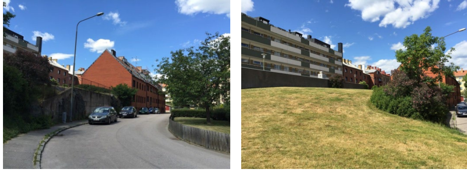
Bild 25 och 26. Stödmuren inom planområdet som ansluter mot Finnagränd samt slutningen i den södra delen av planområdet.
