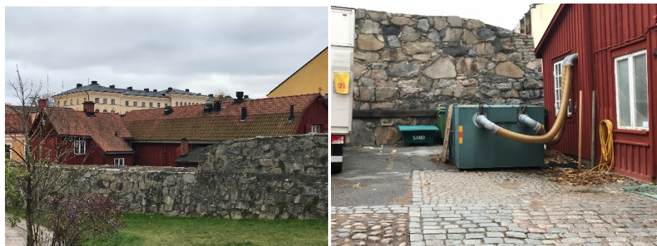
Bild 39. Till höger syns fläktar på taket på Kronostallet. Till vänster syns en container inne på gården i Kronostallet vilken troligt vis ersatt den cyklon som fanns här tidigare, vilken avskiljer stoft, partiklar, damm och spån.
