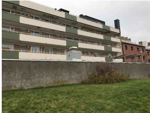
Bild 40. En fläkt som troligtvis ventilerar parkeringsgaraget på von Gerdtén 58. Fläkten gav ett lågt ljud ifrån sig, Fläkten kommer att hamna bara några meter ifrån huset som ska uppföras på von Gerdtén 59.
