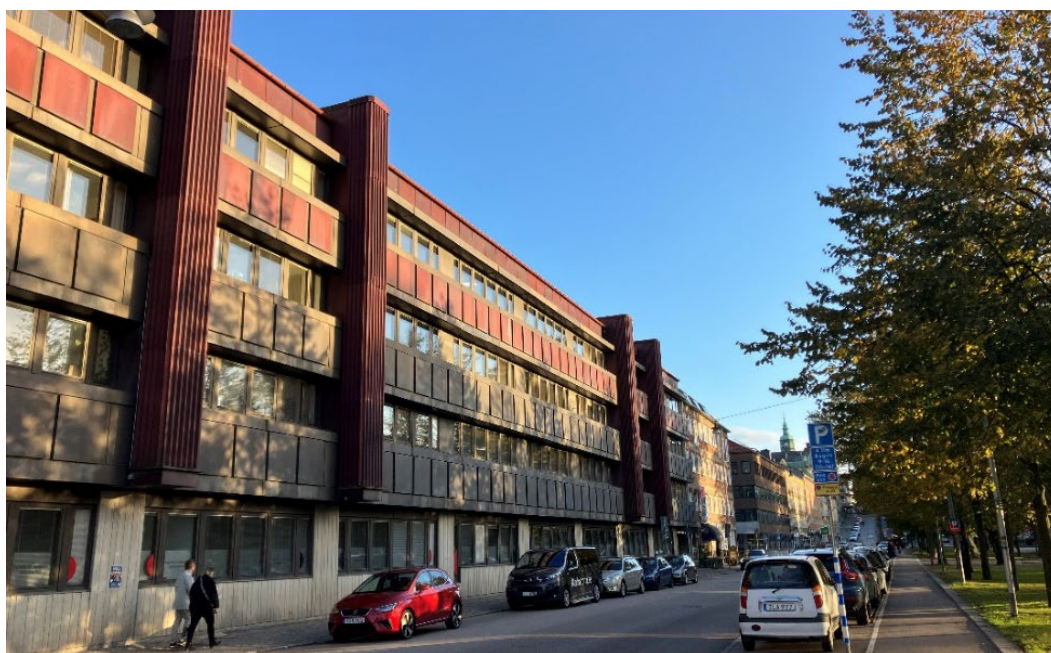
Bild 4. Byggnad för vuxenutbildning syns till vänster i bild.
