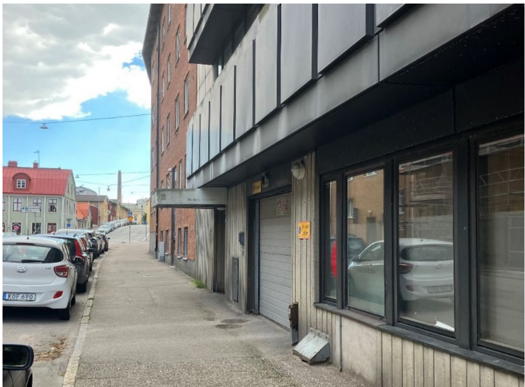
Bild 7. Entré och garageinfart från Östra Vittusgatan, i nordöstra delen av byggnaden.
