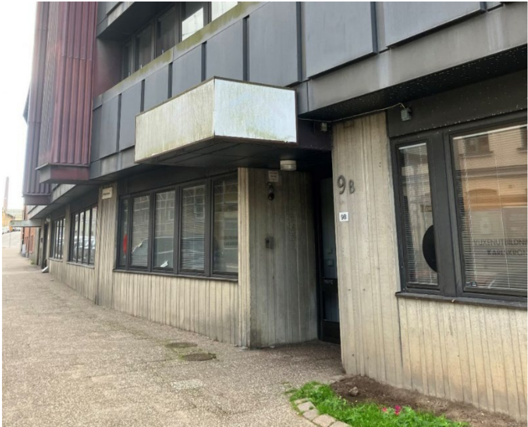
Bild 6. En av entréerna mot Östra Vittusgatan, i nordvästra hörnet på byggnaden.
