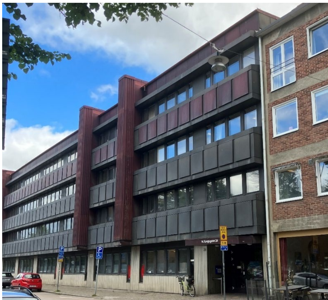
Bild 5. Huvudentré mot Norra Kungsgatan, i södra delen av byggnaden.
