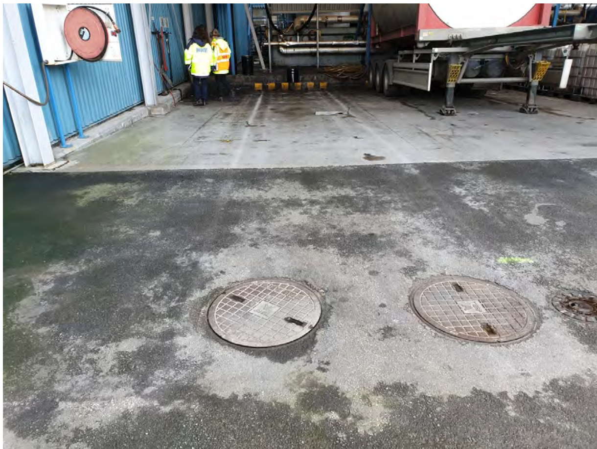
Figur 5: Lossningsplattan, ränna i bakkant leder ev. spill till oljeavskiljare
