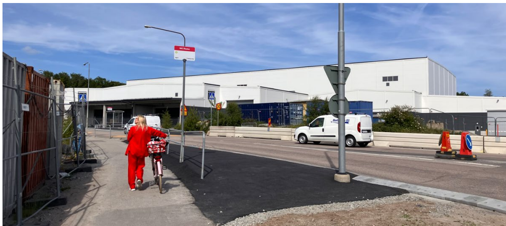
Bild 24. Nyanlagd busshållplats, NKT/Roxtec, väster om NKT:s logistikbyggnad
