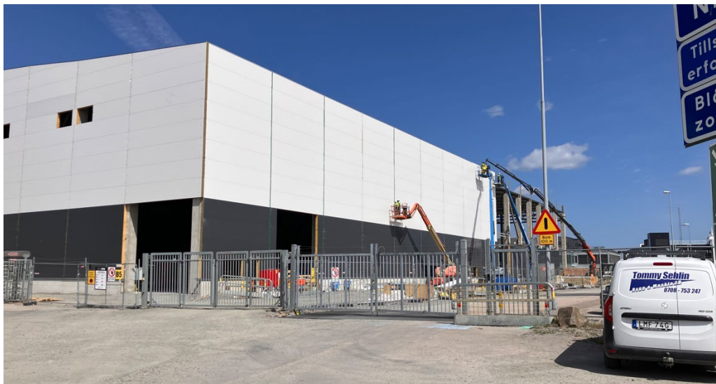
Bild 8. Befintlig byggnad under uppförande norr om Rombvägen.
