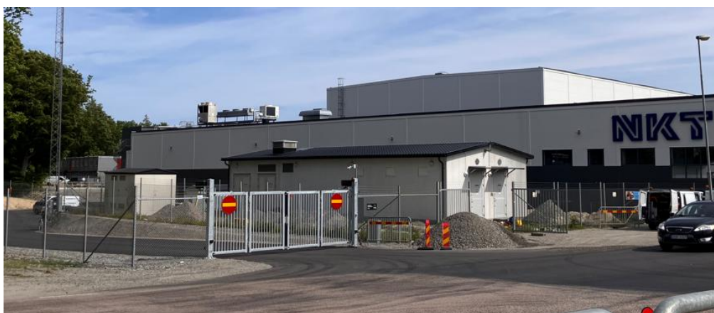
Bild 27. Befintlig nätstation öster om Verkövägen i anslutning till NKT:s logistikbyggnad.
