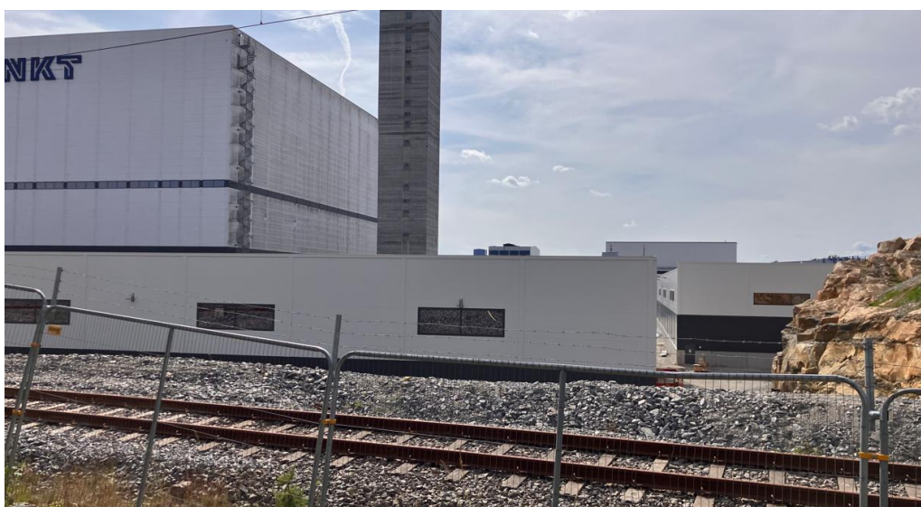
Bild 7. Foto som visar NKT:s verksamhetsbyggnader väster om Verkövägen och järnvägen i norra delen av området.
