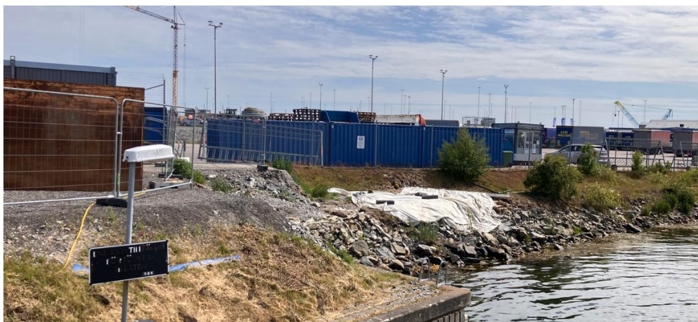
Bild 21. Foto som visar hur det ser ut norr om KBP:s staket där det enligt gällande detaljplan finns en planlagd gångväg.
