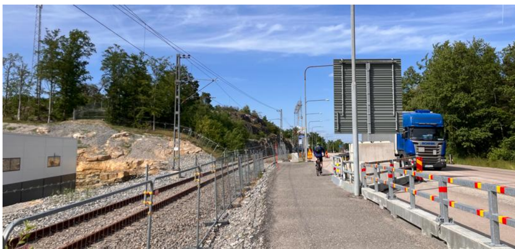
Bild 26. Vy från Verkövägen mot norr där föreslaget läge för nya anläggningar är på spårområdet.
