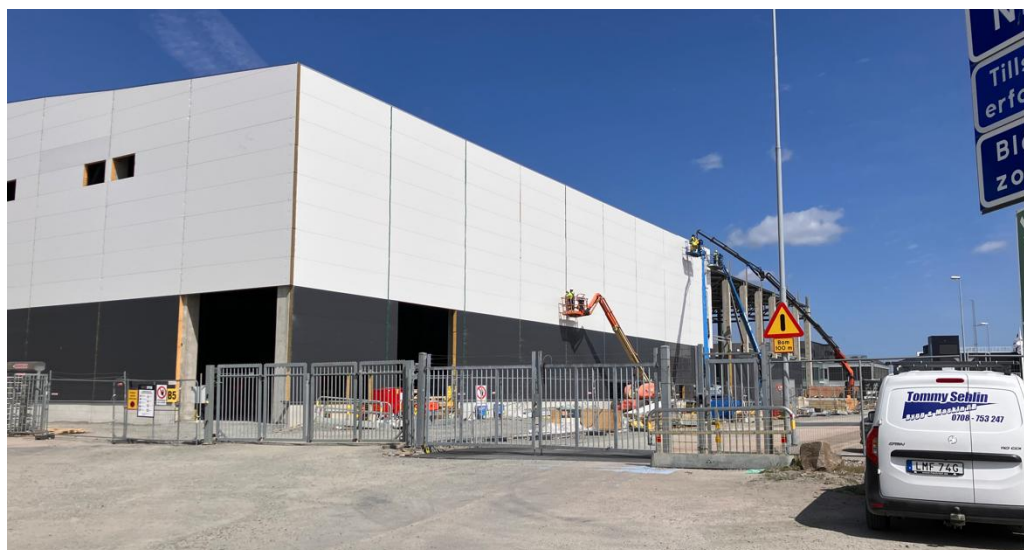
Bild 8. Befintlig byggnad under uppförande norr om Rombvägen.
