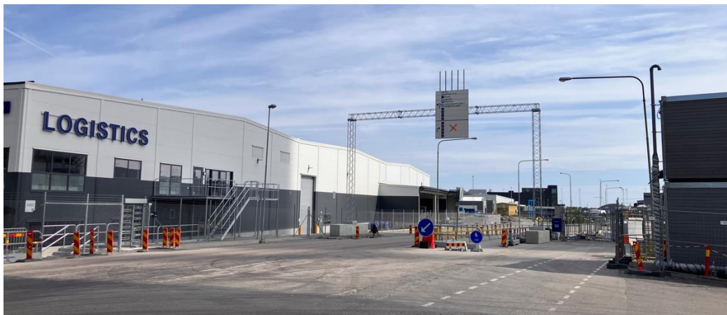
Bild 5. Foto som visar NKT:s logistikbyggnad öster om Verkövägen. Bilden är tagen från norr.
