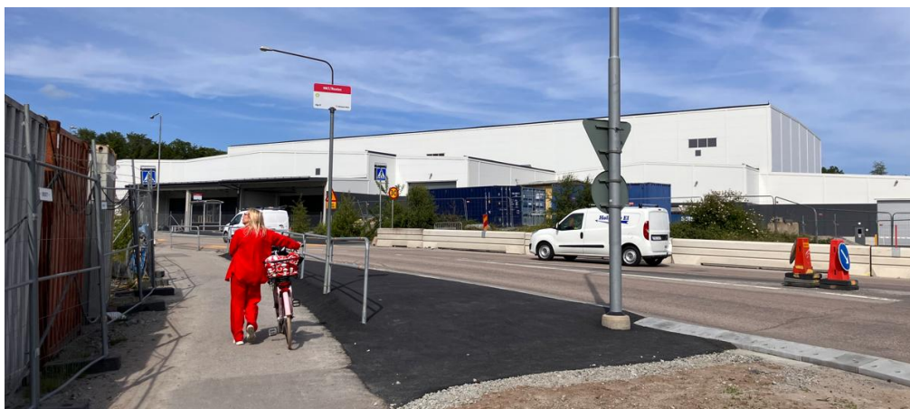
Bild 24. Nyanlagd busshållplats, NKT/Roxtec, väster om NKT:s logistikbyggnad
