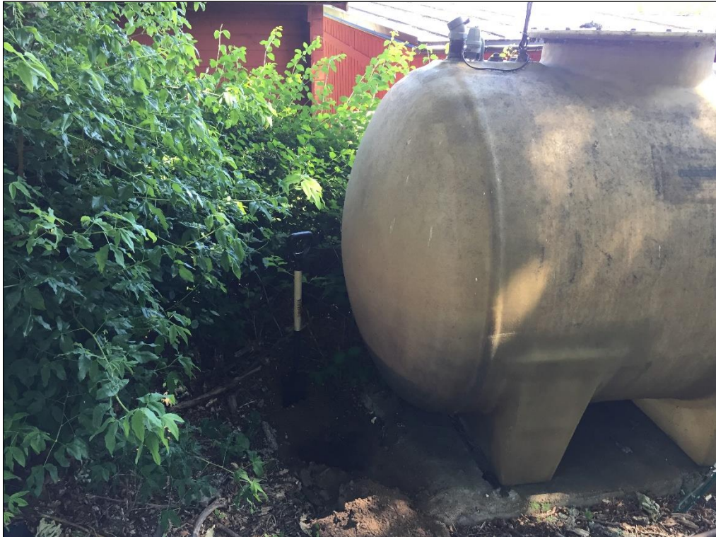
Figur 3. Provtagningspunkt BH1 vid oljecistern. Provtagningen genomfördes ner till 0,5 m.u.my under påfyllningsröret. Inga tecken på förorening dokumenterades under provtagningstillfället.
