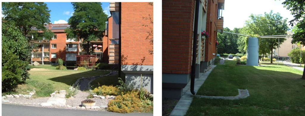
Foto 3: Avledning/infiltation via ytliga stråk, bräddutlopp via förhöjd kupolsil. Inspektoren, Kalmar
