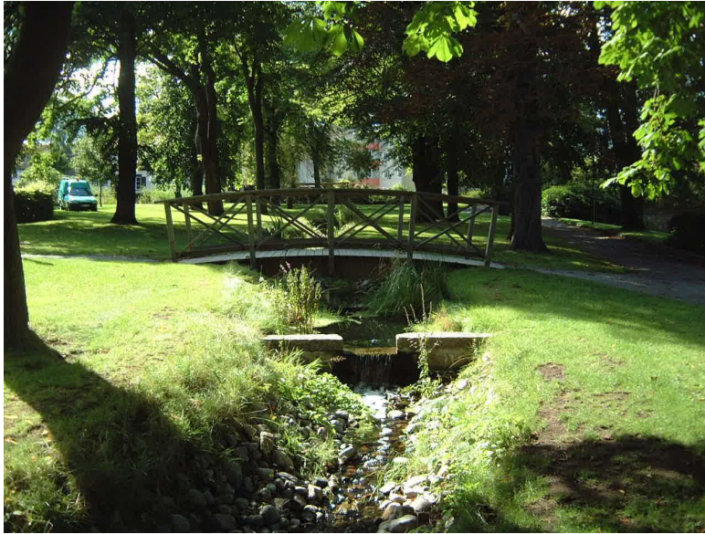
Foto 1: Dagvattendike Västerviks stadspark, vattnet recirkulerar med pumpning under perioder med låg eller ingen tillrinning.
