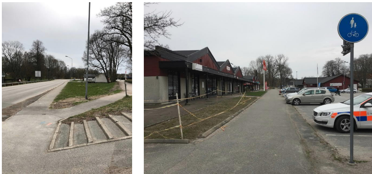
Figur 9 Cykelväg mot söder utmed väg 678 norr om Nättraby centrum (vänstra bilden) och cykelvägen genom centrum (högra bilden)
