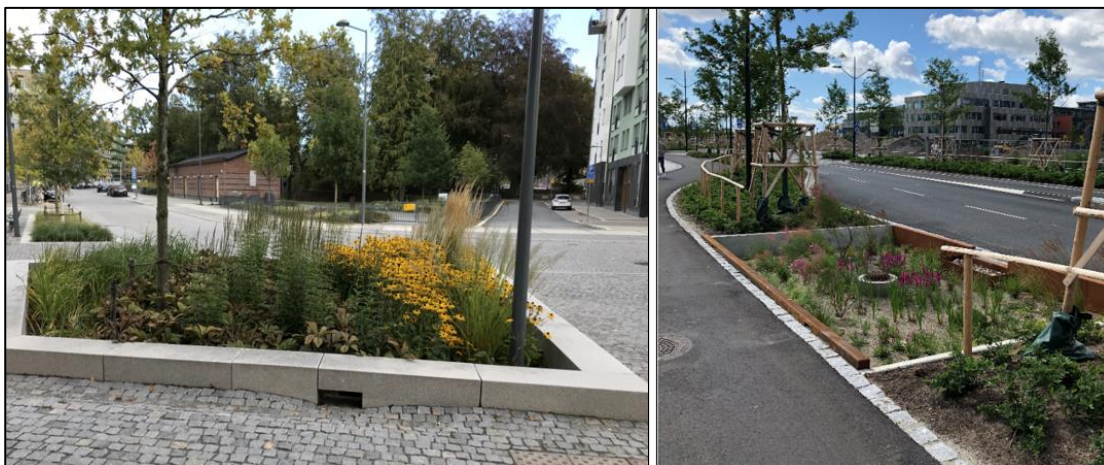
Figur 9. Exempel på nedsänkta regnbäddar (Foton: Norconsult)
