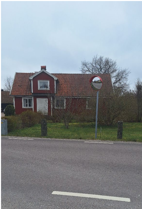
Bild 11. Befintlig siktåtgärd i korsningen Träsmedsvägen och Jämjövägen, på grund av begränsad sikt.
