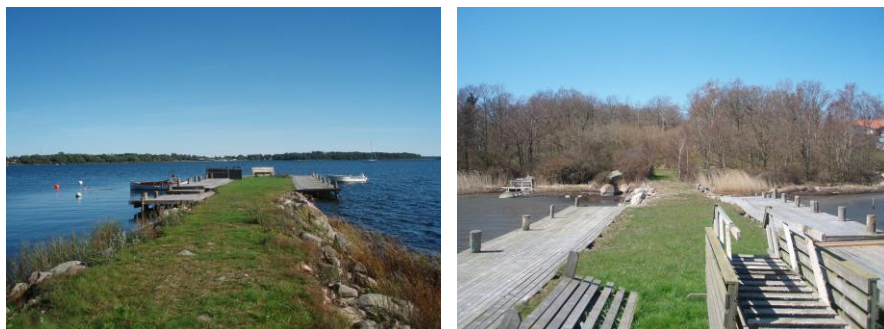
Befintlig samfälladgå brygga.
