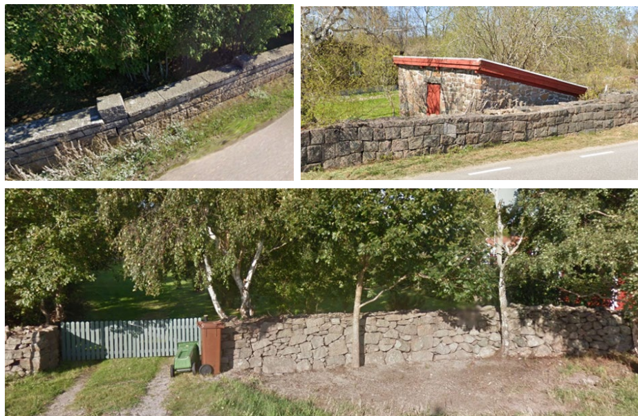
Bild 66–68. Befintliga stenmurar på Tjurkö
