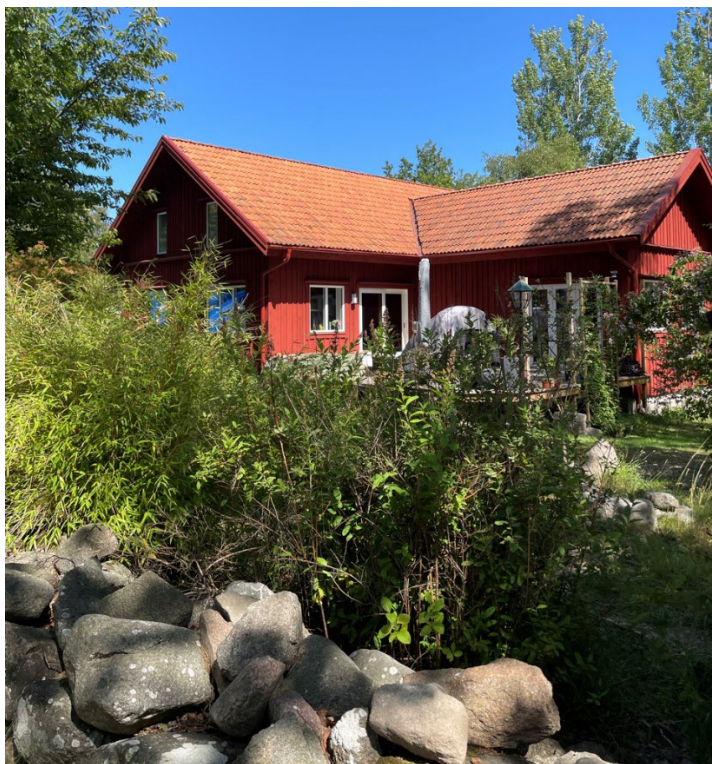
Bild 14: Bilden visar exempel på ny byggnad i närområdet som anpassats väl utifrån värden kopplat till riksintresset. Byggnaden har stående träpanel målad med röd slamfärg. Taket är ett sadeltak med 34 graders taklutning och röda tegelpannor. Byggnaden uppfyller föreslagna planbestämmelser och skulle kunna uppföras inom hela planområdet. (Foto: Karlskrona kommun).
