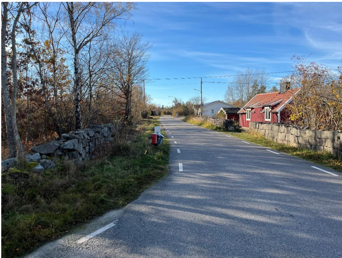
Figur 13. Vägrenen föreslås breddas med cirka 1,5 meter till vänster i bild om Norra Tjurkövägen. Det medför att postlådområdet behöver flyttas. Den aktuella busshållplatsen är belägen hitom det vita huset.
