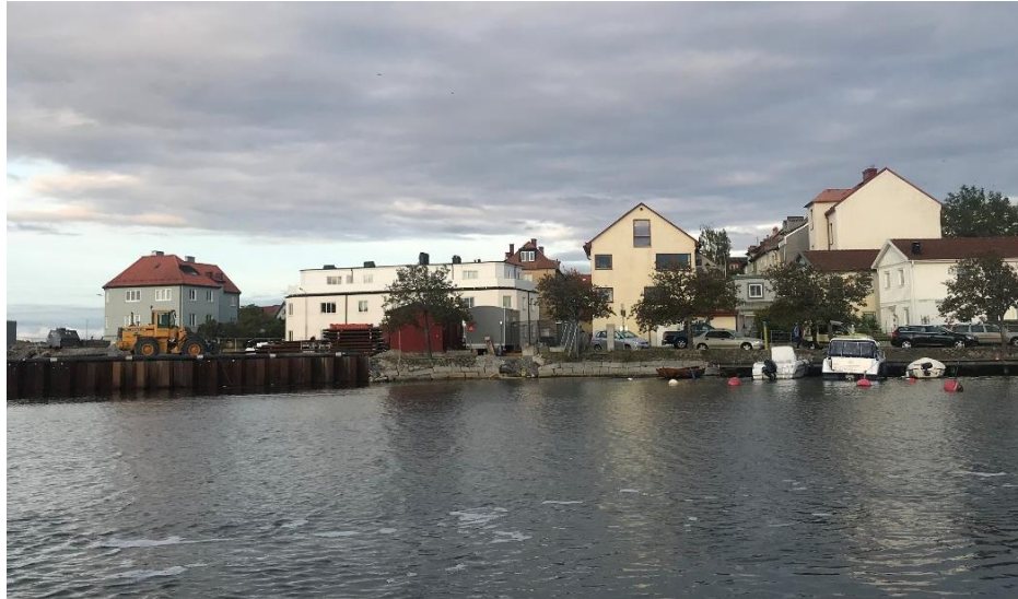
Bild 7. Befintlig bebyggelse sett från väster.
