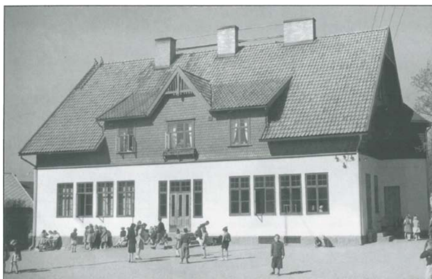
Bild 35. Senare bild på folkskolebyggnaden där taket är i tegel och fasaden är tvåfärgad.
