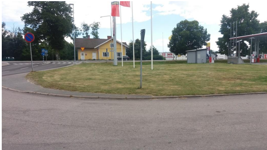
Figur 16 Möjlig plats för förläggning av kulvert under Stationsvägen väster om utfarten till Stationsvägen.
