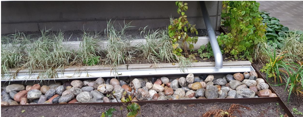
Figur 13. Stensatt rännadal med växtbädd, Norra Djurgårdsstaden Stockholm.
