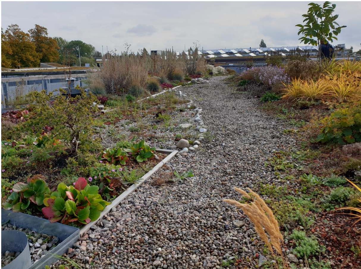
Figur 9. Ett intensivt grönt tak som fungerar som en takträdgård i Augustenborg Malmö, foto från WSP 2019.
