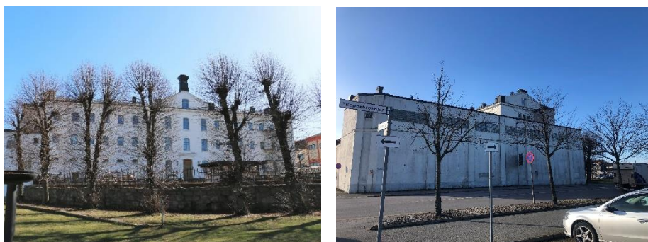
Bild 34-35. Angränsande bebyggelse med det f.d. fängelset sett från väster och norr.
