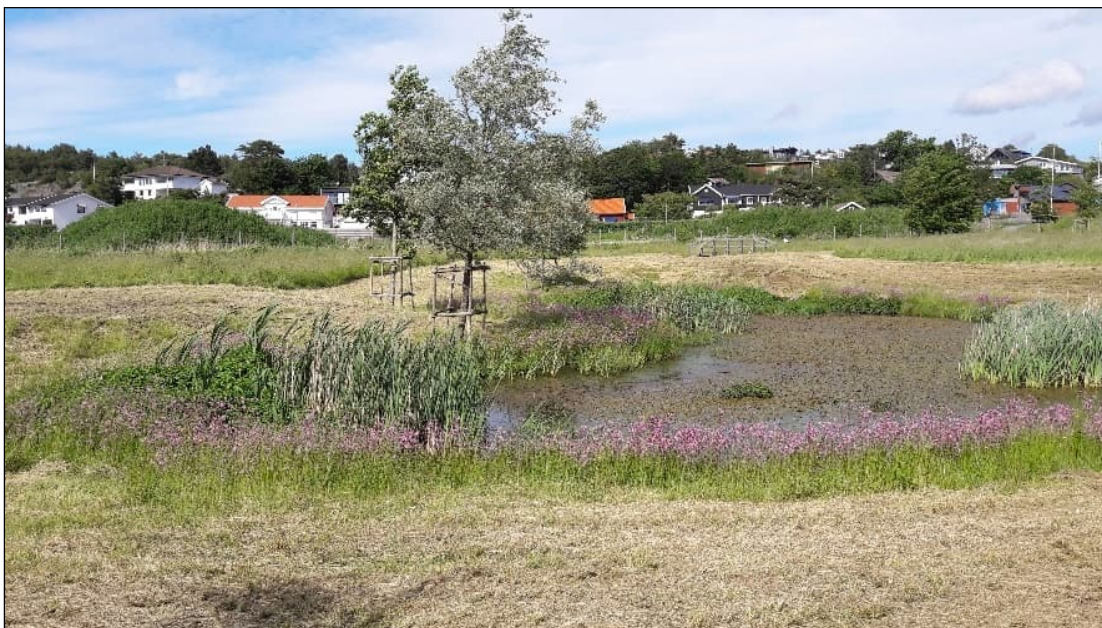
Figur 17: Exempel på dagvattendamm i Brottkärr (Foto: Norconsult).
