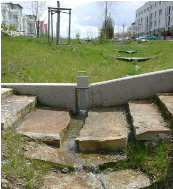
Figur 13: Exempel på dagvattendike med fördröjning i Kronsberg, Tyskland (Foto: Norconsult).
