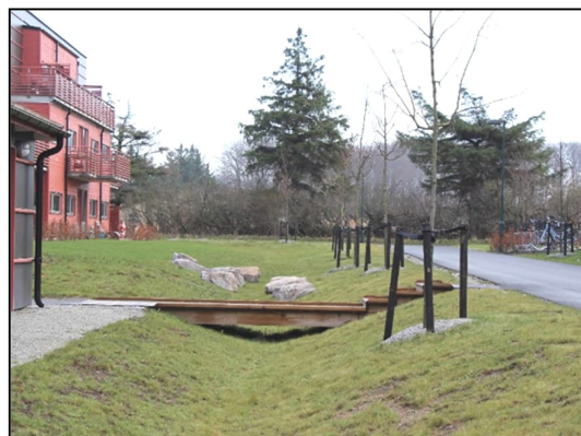
Figur 14: Typsektion och exempel på svackdike i Gyllins trädgård, Malmö (Foto: Norconsult).
