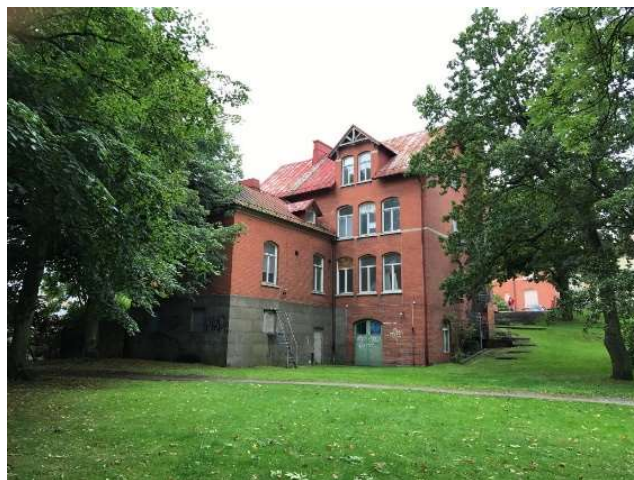
Bild 65. Befintlig tegelbyggnad sett från parkområdet vid Polhemsgatan. Byggnaden är uppförd 1902 och innehöll bland annat expedition.
