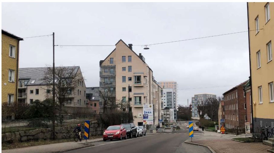
Bild 17. Planerad ny bebyggelse sett från Landsvägsgatan i söder. Fotomontaget är endast en volymsskiss och visar inte den slutliga utformningen av husen. Fotomontage Karlskrona kommun / Möller Arkitekter.
