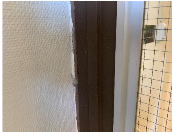
Foto 28. Grå/brun fog vid dörrparti innehåller inte PCB eller klorparaffiner, verifierat via prov 200227:27.
