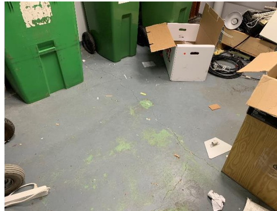
Foto 18. Färg på golv på plan 0 (samlingsprov) innehåller höga halter barium men inte över FA, verifierat via prov 200227:3.
