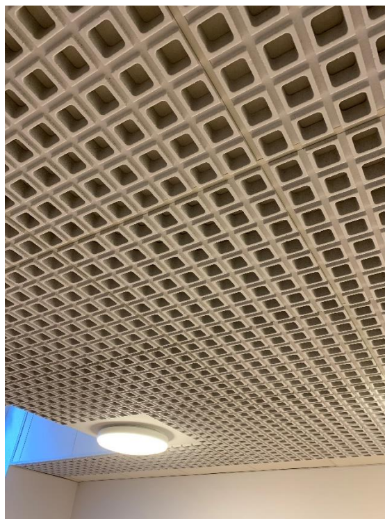
Foto 22. Ljudisolerande platta i tak innehåller inte asbest, verifierat via prov 200227:12.
