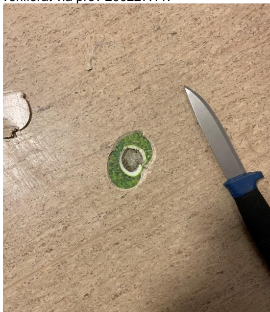
Foto 23. Grön golvmatta (under nyare golvmatta) innehåller inte asbest, verifierat via prov 200227:13.
