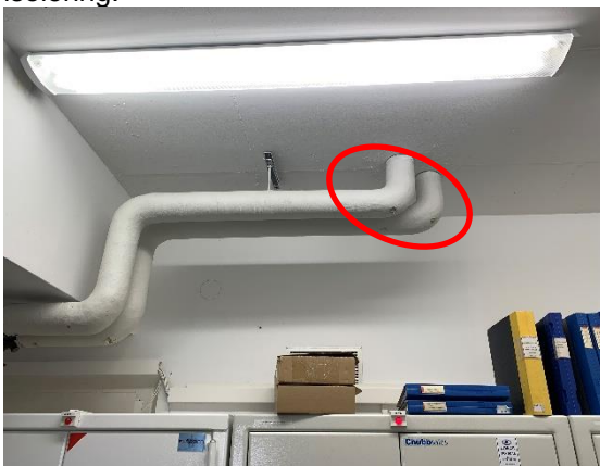
Foto 11. Isolering i rörböjar/förgreningar samt avslut innehåller asbest (okulär bedömning). Även trasiga rörböjar förekommer.
