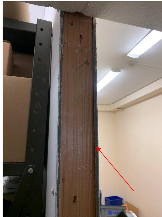
Foto 10. Eternitskivor förekommer i skiljevägg på plan 1 (okulär bedömning).
