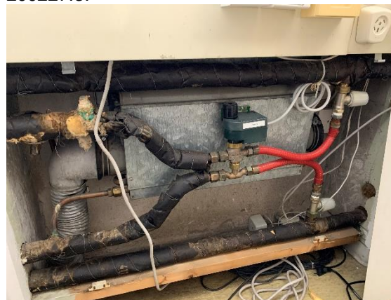
Foto 20. Svart papp runt rör innehåller inte asbest eller höga halter av PAH, verifierat via prov 200227:15.
