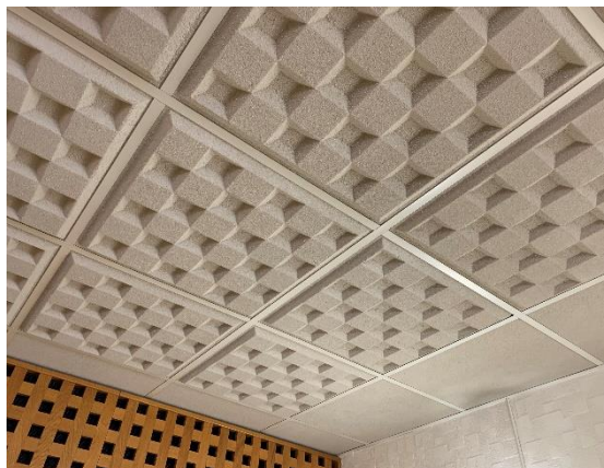
Foto 19. Ljudisolerande skiva i tak innehåller inte asbest, verifierat via prov 200227:7.
