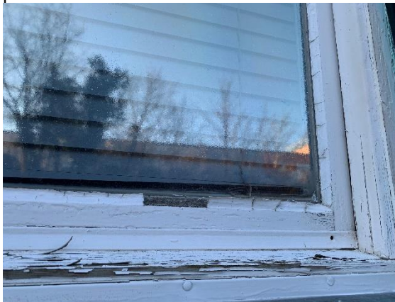
Foto 27. Fönsterkitt (utvändigt) innehåller inte asbest, verifierat via prov 200227:25.
