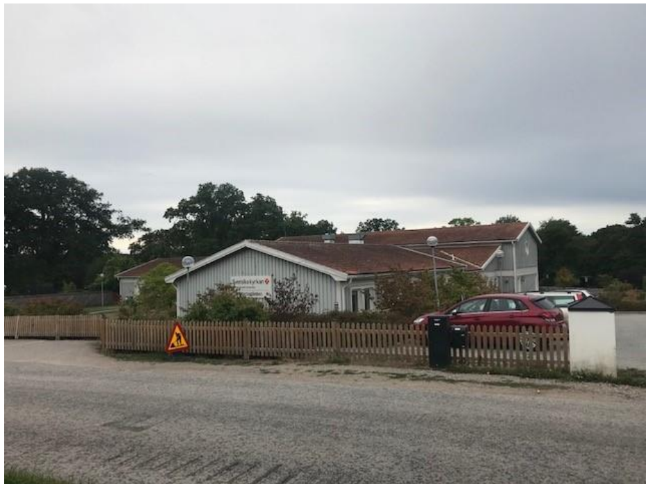
Bild 3. Befintlig byggnad sedd från Kyrkovägen.
