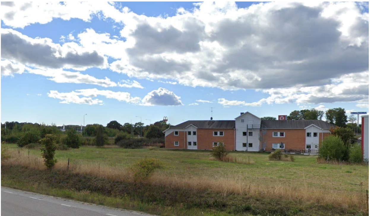
Bild tagen från Vedeby gata över fastighet Motorn 3, Karlskrona (Google Maps, Street View, 2023).
