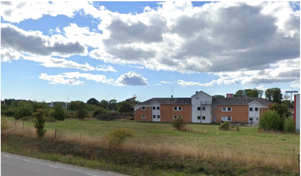
Bild tagen från Vedeby gata över fastighet Motorn 3, Karlskrona (Google Maps, Street View, 2023).
