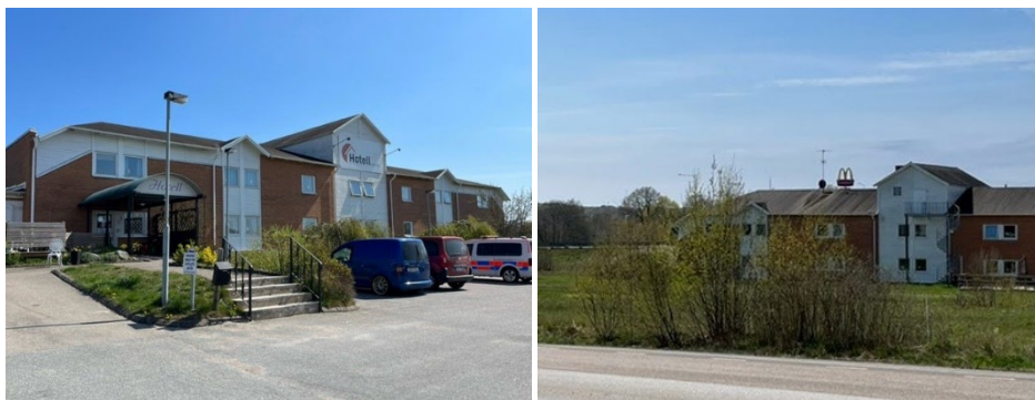
Bild 8-9. Befintlig byggnad inom planområdet.
