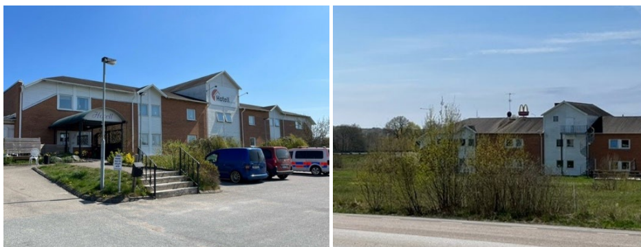
Bild 9-10. Befintlig byggnad, Hotell Angöringen, inom planområdet.
