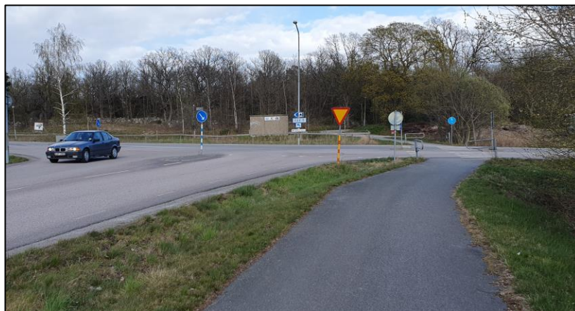
Figur 8. Befintlig gång- och cykelpassage vid korsningen August Palmgrens väg / Vedeby gata.
