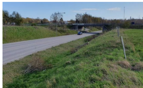
Bild 27. Vedeby gata i sydlig riktning mot E22.
