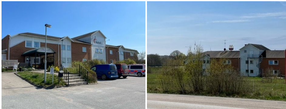
Bild 9-10. Befintlig byggnad, Hotell Angöringen, inom planområdet.
