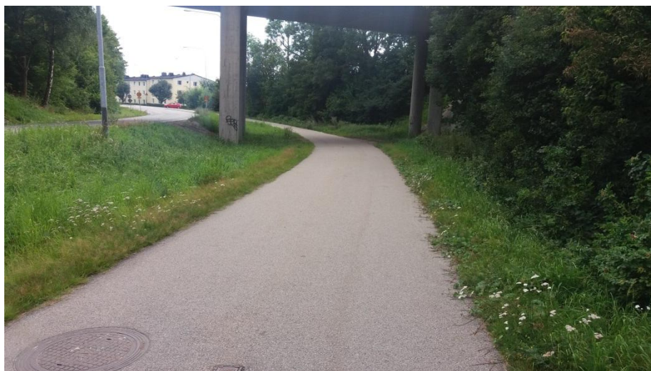
Figur 7 Platsen där vatten rinner vidare till Axel W Anderssons väg. Ett möjligt åtgärdsförslag är att höja cykelvägen till samma nivå som bilvägen.
