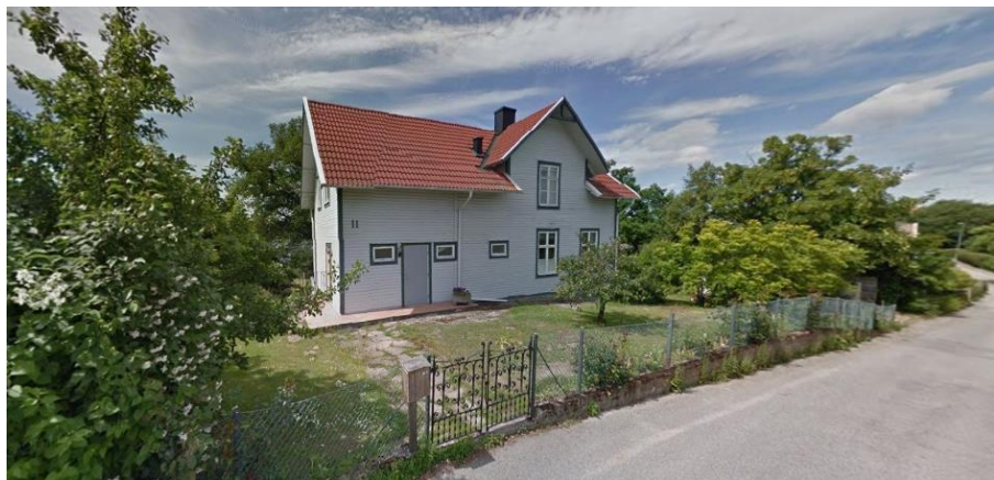
Bild 5 Befintligt byggnad inom planområdet
