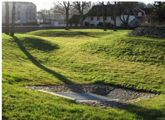
Bild 17: Exempel på översvämningsyta (foto Malin Engström, Växjö kommun)
