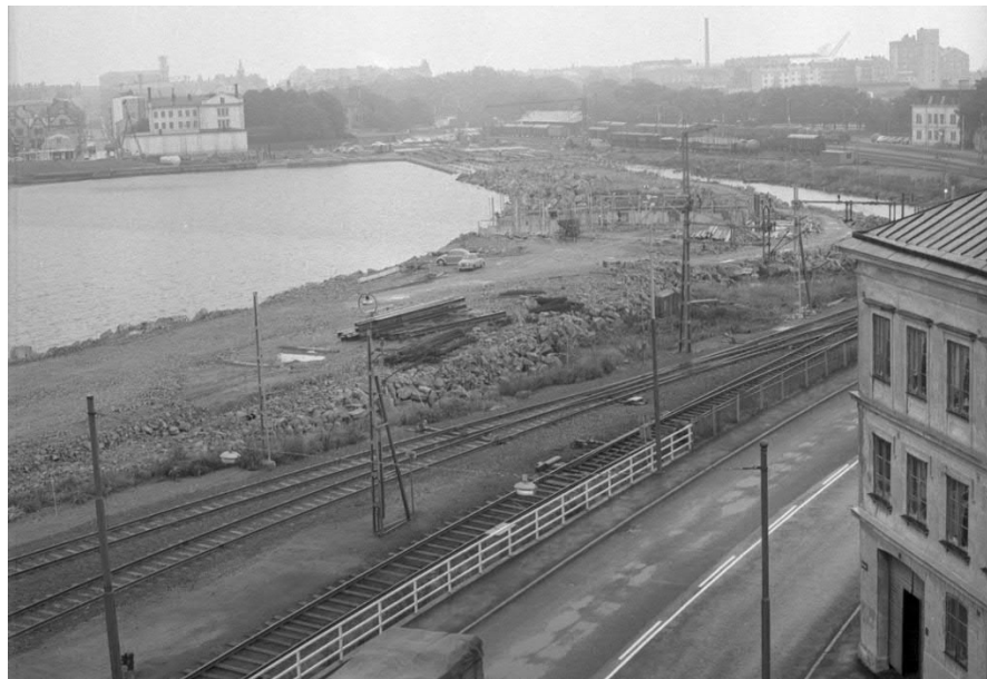
Figur 5 Fotografi som visar utfyllnadsarbeten i samband med ny dragning av Österleden, ca 1970. © Blekinge museum.
