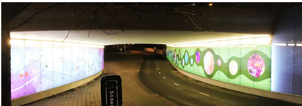
Figur 5-4 Exempel på hur målning och belysning kan skapa en tryggare gång och cykeltunnel. Nobeltunneln i Malmö 11
