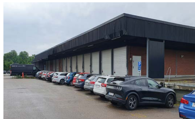
Godsmagasinetns östra sida.
