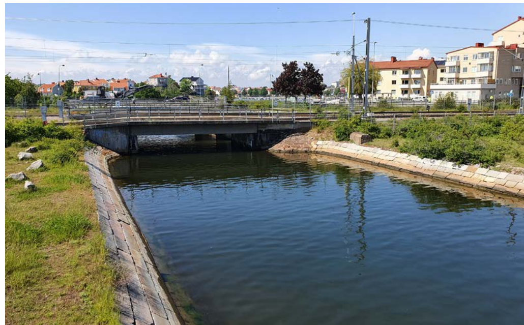
Vattnet mellan Pottholmen och Pantarholmen, den sk Brohålan. Vy mot väster. Stenskodda kanter från 1960/70-tal när marken här fylldes ut i samband med bygget av Österleden.
