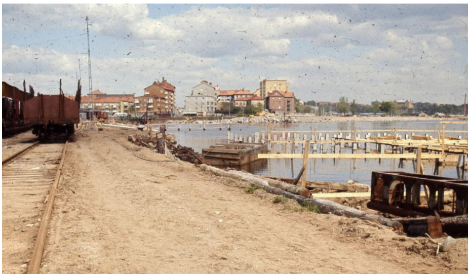
Påbörjat vägarbete längs järnvägsspåren 1970. Pantarholmen i bakgrunden. Foto G. Lindahl. Källa: Alvin/Kungl. Konsthögskolan.
