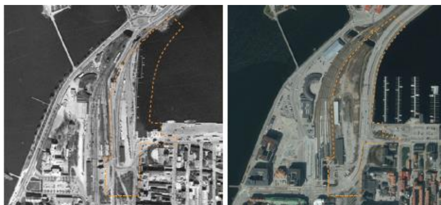
Bild 44-45. Ortofoto från 1961 innan Österledens utbyggnad samt ortofoto från 1975 då Österleden är utbyggd och marken utfyllt. Planområdet är rödmarkerat.
