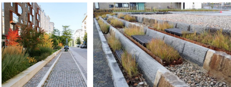
Exempel på regnbäddar som filtrerar och fördröjer dagvattnet. Till vänster Norra Djurgårdsstaden i Stockholm och till höger från Oslo. Foto: Kasper Dudzik och Itu.se.
