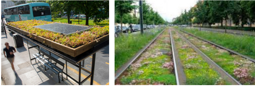
Exempel på multifunktionella lösningar. Spårrområde med grönska och busshållplats med grönt tak såväl som solceller. Exempel från Brighton and Hove och Berlin. Foto: Brighton & Hove City Council och Ssb-ag.de.
