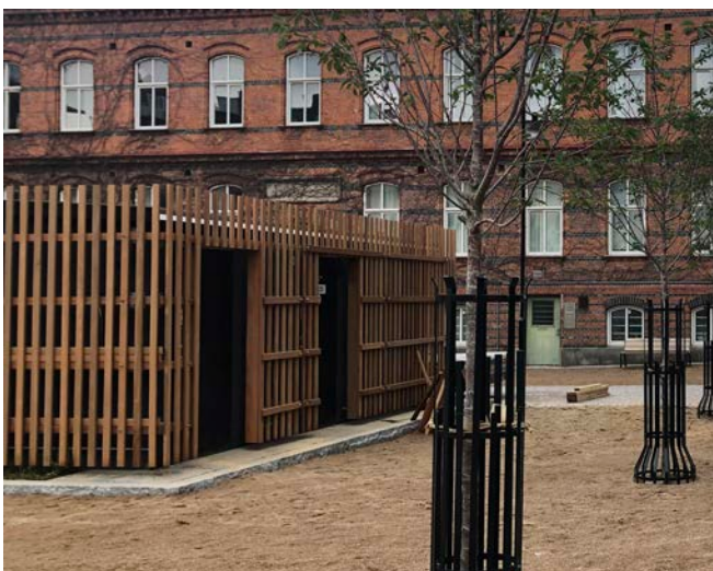
Referensexempel på gestaltning av transformatorstationer på Pottholmen etapp 1.
