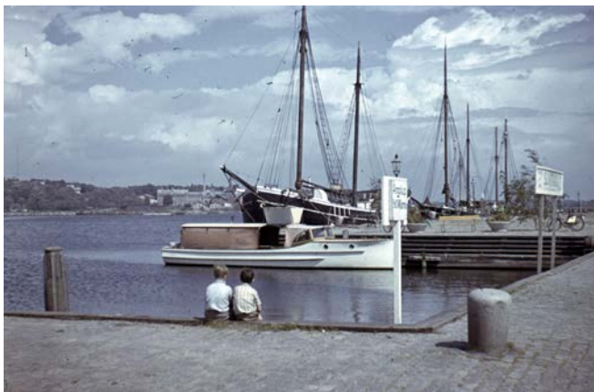
Det tidigare indragna vattenrummet vid Skeppsbron på 1950-talet.
