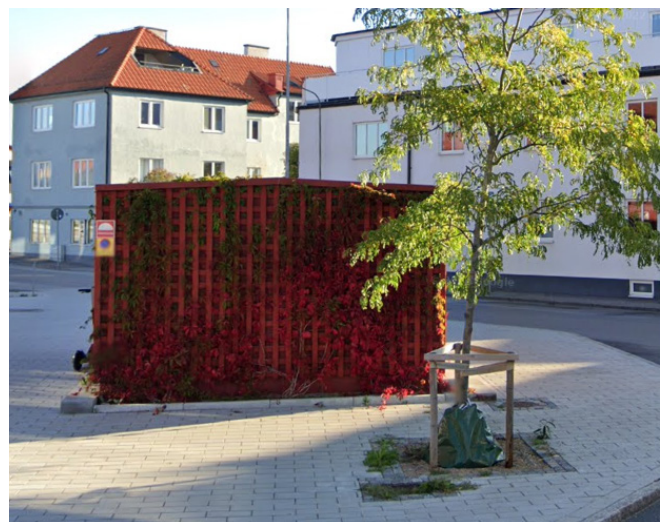
Referensexempel på gestaltning av transformatorstationer vid Kilströmskaj.
