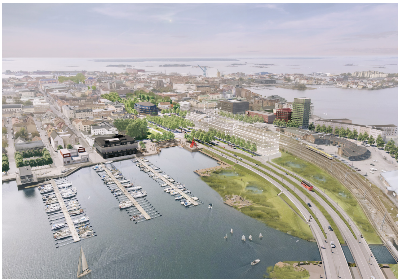
Bild 2. En utbyggnad av Pottholmen etapp 2 del 1 omfattar en omlokalisering och omgestaltning av Österleden samt utveckling av flera allmänna platser.
